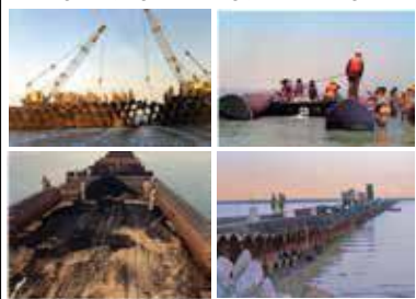
مراحل ساخت و بهره‌برداری از پل بعثت
