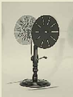
فناکیستوسکوپ، صفحه‌مدور گردنده‌ای که تصاویر بر آن رسم شده‌اند تا بیننده از درون یکی از شکاف‌ها توهم حرکت را تماشا کند.
