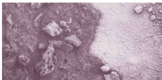
تصویر ۹: نشان‌دهنده بتن پر مقاومت بارگذاری نشده است.
