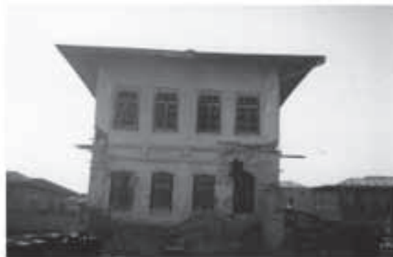
تصویر ۱۴. نمونه‌ای از خانه‌ی قدیمی در حال تخریب
