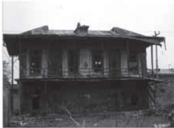
تصویر ۱. بنای دو طبقه
