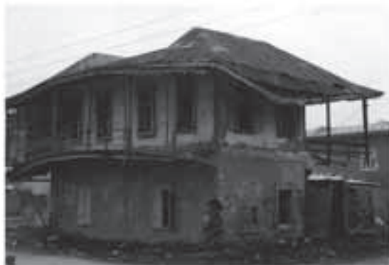
تصویر ۱۵. نمونه‌ای از خانه‌ی قدیمی در حال تخریب
