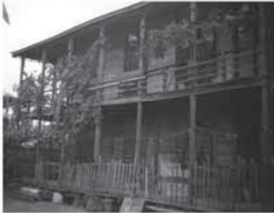
تصویر ۲. بنای دو طبقه
