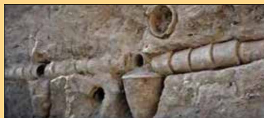
سفالینه‌های موجود در حمام شیخ بهایی برای انتقال گاز
