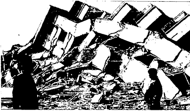
شکل ۱. خرابی ناشی از زلزله
