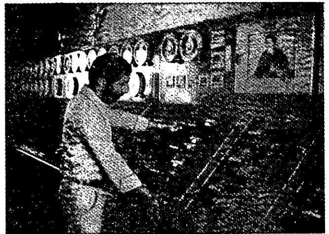
یک تکنیسین در حال کنترل شیرهای نفت جزیره خاک
