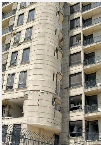
تصویر ۱: ریزش خانه بر اثر ساخت در دامنه و رانش زمین؛ سعادت آباد
