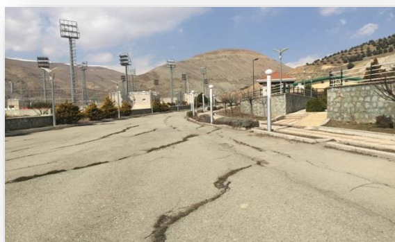
تصویر ۲: شکاف‌های طولی به دلیل در نظر نگرفتن زمین‌ساخت فعال منطقه (خیابان جلوی ورزشگاه فتح دانشگاه علوم تحقیقات)
