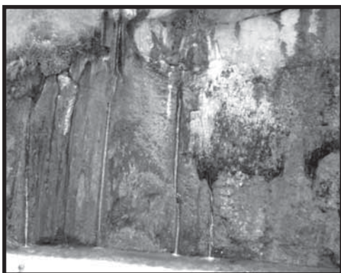
تصویر ۴. حفرات ایجاد شده در لایه تخریبی، محل خروج آب از لایه آبدار پشت دیوار آبشار را نشان می‌دهد.
