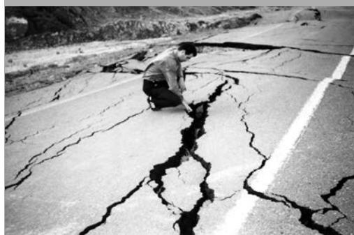
تصویر ۹. ایجاد شکستگی‌های فراوان در جاده جابه‌جا شده شامل دو نوع شکستگی کششی موازی با جاده (۱) در نتیجه حرکات کششی و شکستگی‌های برشی عمود بر جاده (۲) ناشی از اختلاف میزان حرکت دو طرف شکستگی
