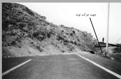
تصویر ۵. جابه‌جایی جاده همراه با توده لغزش یافته
