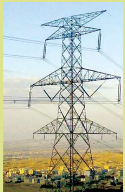
▲ این دکل برق با این که از میله‌های نازکی ساخته شده است، به خاطر شکل هندسی آن مقاومت زیادی دارد.
